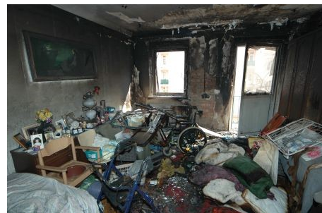
Viele solcher Schäden könnten vermieden werden.
